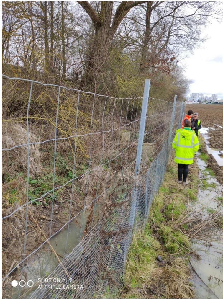
Figure 42 C:\Users\m_cha\Desktop\Heudebouville SAPN\photos\2020-02-05_14-32-20.jpg bv4 : Aperçu de l'entonnement amont de l'ouvrage D500
