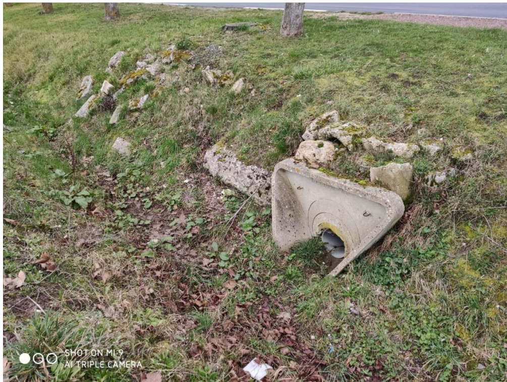
Figure 6 C:\Users\m_cha\Desktop\Heudebouville SAPN\photos\bv1\2020-02-05_17-38-10.jpg bv1 : Vue du D300 PVC dans le fossé amont de la RD
