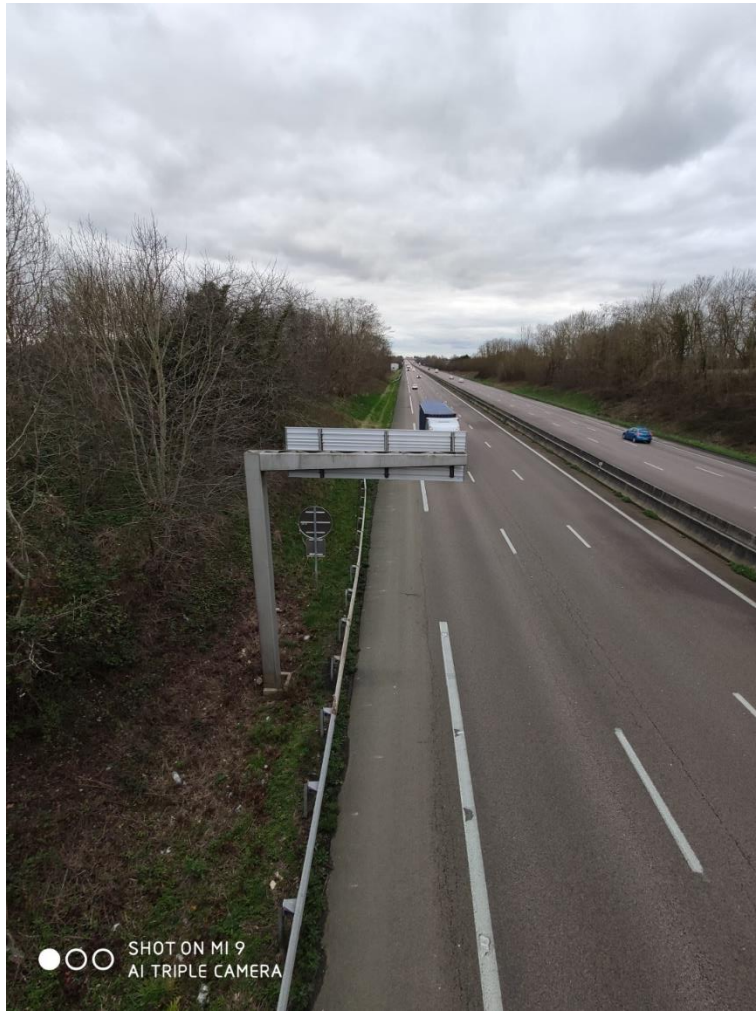
Figure 11 C:\Users\m_cha\Desktop\Heudebouville SAPN\photos\bv1\2020-02-05_16-47-42.jpg bv1 : Aperçu de l'assainissement lateral A13 (PS Vironvay)
