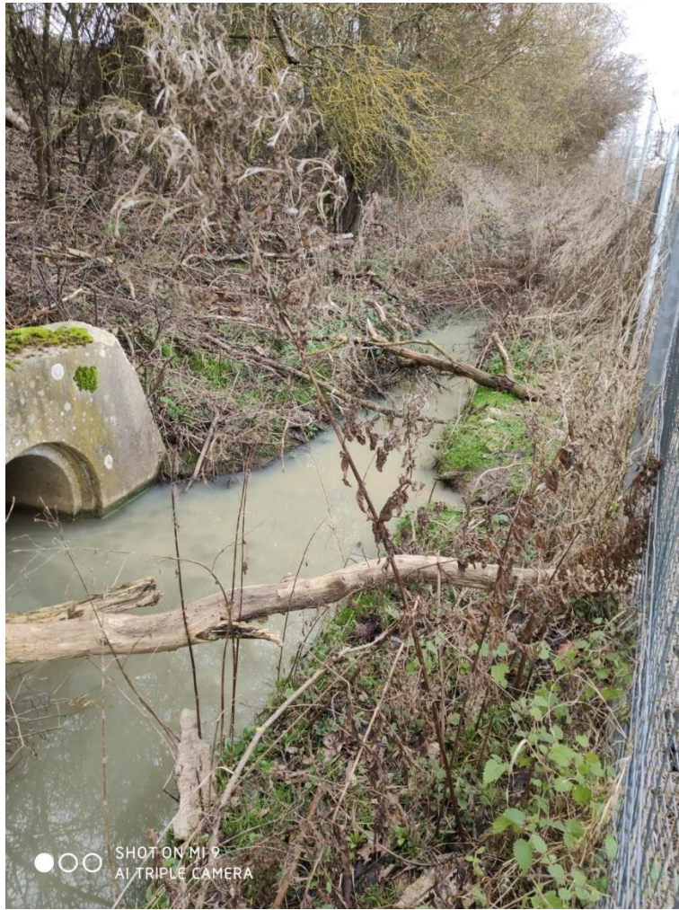
Figure 4o C:\Users\m_cha\Desktop\Heudebouville SAPN\photos\2020-02-05_14-34-35.jpg bv4 : Connexion de l'ouvrage D500 et du fossé de remblai
