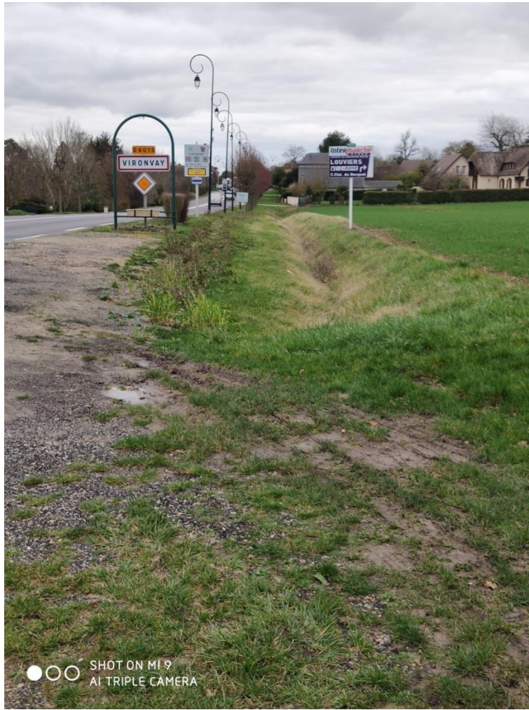
Figure 13 C:\Users\m_cha\Desktop\Heudebouville SAPN\photos\bv1\2020-02-05_16-44-42.jpg bv1 : Fossé lateral amont RD en direction de Vironvay
