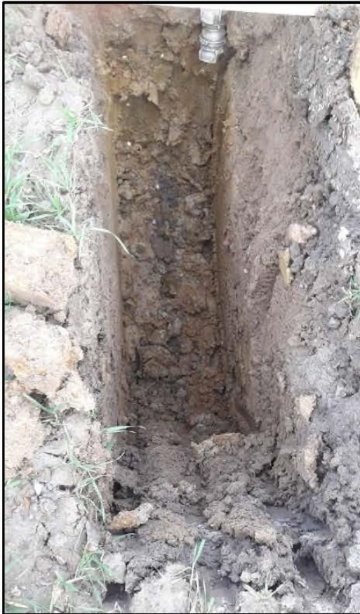
Photographie de la fouille pour l'essai de perméabilité EPM2 avant remplissage
