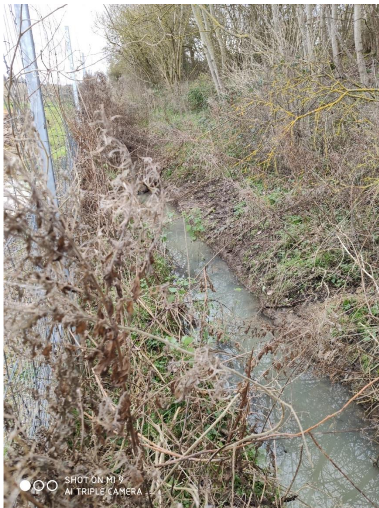
Figure 39 C:\Users\m_cha\Desktop\Heudebouville SAPN\photos\2020-02-05_14-34-42.jpg. bv4 : Aperçu du talus de remblai de l'A13
