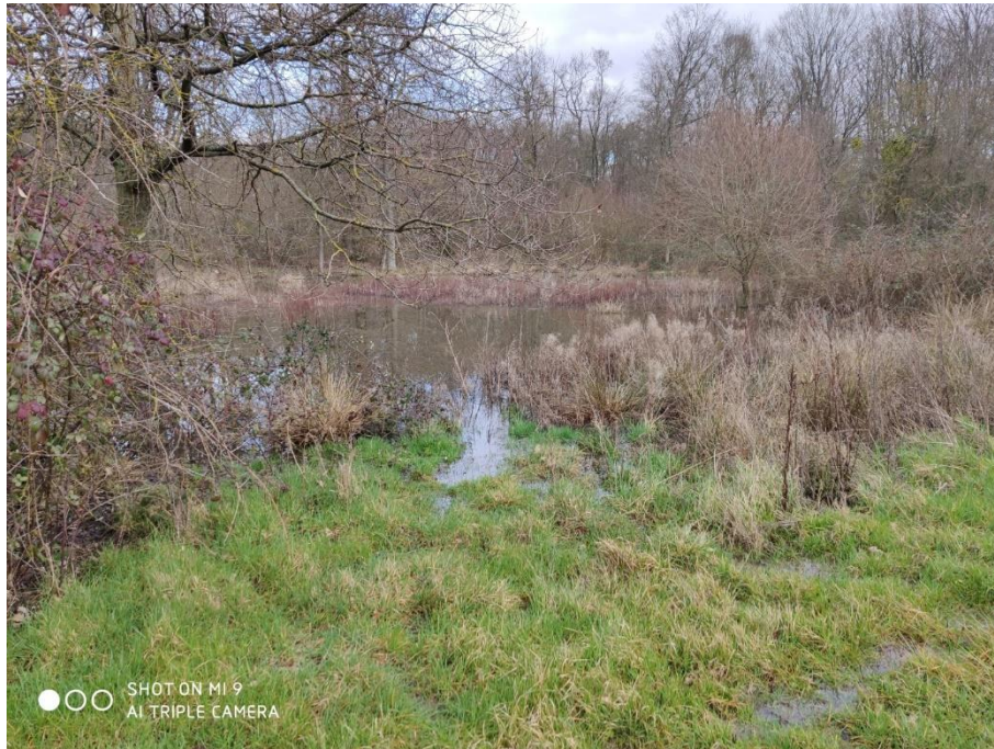
Figure 23 C:\Users\m_cha\Desktop\Heudebouville SAPN\photos\bv2\2020-02-05_15-05-09.jpg bv2 : idem avec suintement aval
