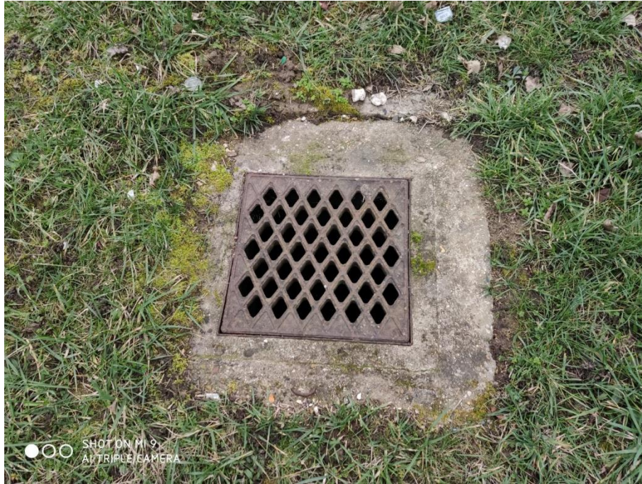
Figure 33 C:\Users\m_cha\Desktop\Heudebouville SAPN\photos\bv3\2020-02-05_16-58-51.jpg bv3 : regard sur D500 en bordure de la RD
