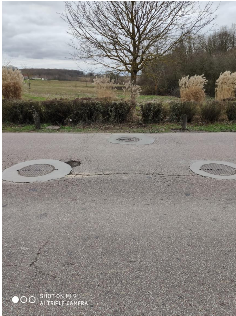
Figure 30 C:\Users\m_cha\Desktop\Heudebouville SAPN\photos\bv3\2020-02-05_17-06-52.jpg bv3 : Réseau pluvial à l'aval ZAC (point-bas)
