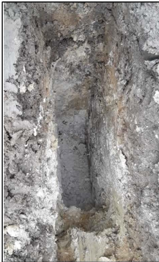
Photographie de la fouille pour l'essai de perméabilité EPM3 avant remplissage
